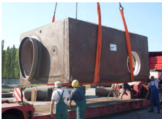
Exemple pentru structuri de cămine fabricate individual
